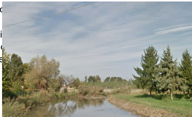
Tratto Canale Diversivo di Cavezzo in corrispondenza dell'attraversamento della S.P. 5
