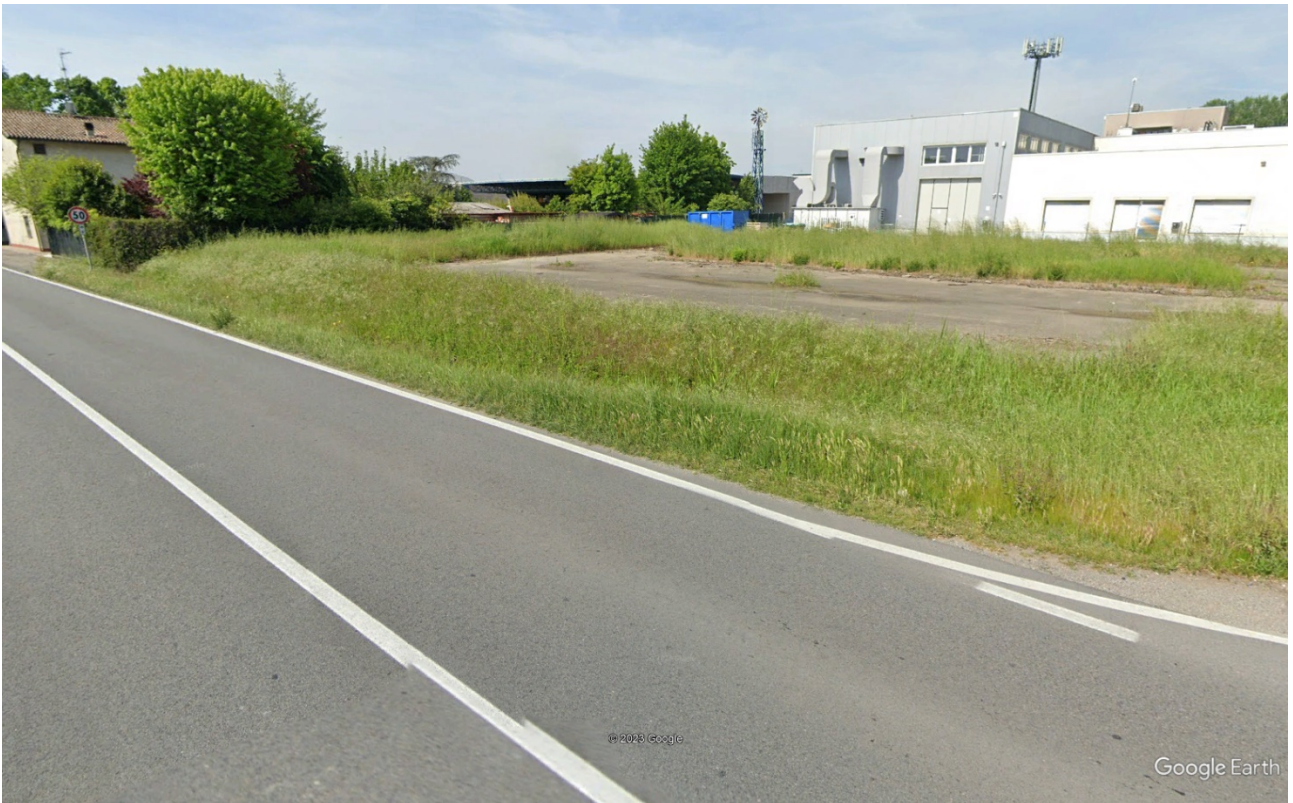
Figura 3: Inquadramento fotografico – parcheggio antistante stabilimento Emotec s.r.l. e fosso stradale.
