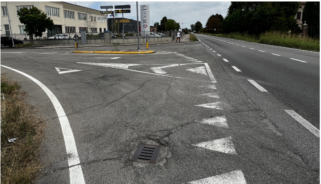
Figura 4: Inquadramento fotografico – angolo Via Maestri del Lavoro e S.S: 12 - ciclopedonale esistente.
