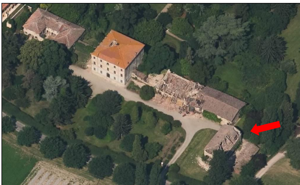
Fig. 14 – Vista aerea dei danni da sisma, post 2012. La freccia rossa indica l'immobile oggetto della presente relazione.
