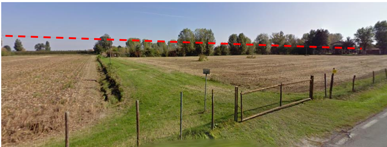
Figura 10 Accesso allo stradello che porta al cantiere ubicato in prossimità della sponda sud del lago – In rosso evidenziazione dei linea elettrica aerea esistente
